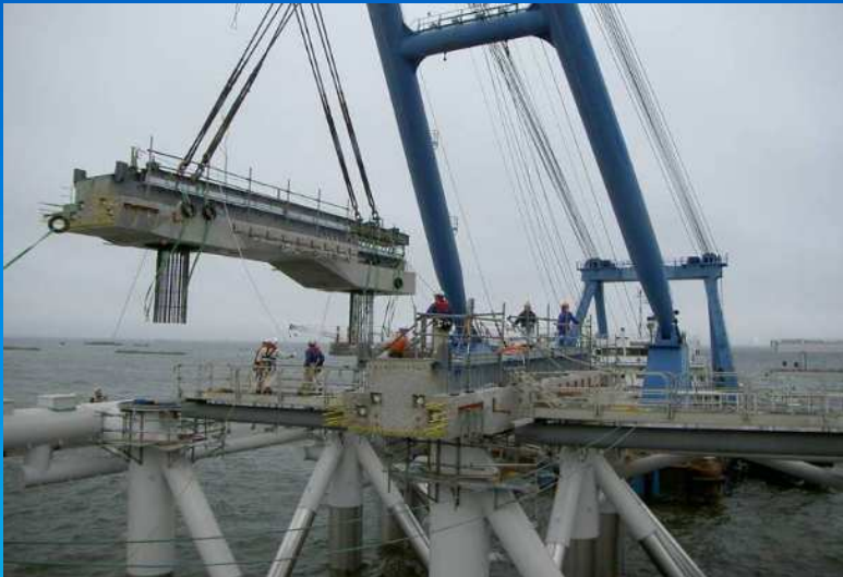
受桁設置状況
