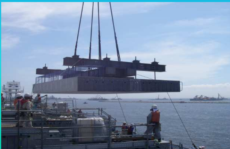
床版設置状況
