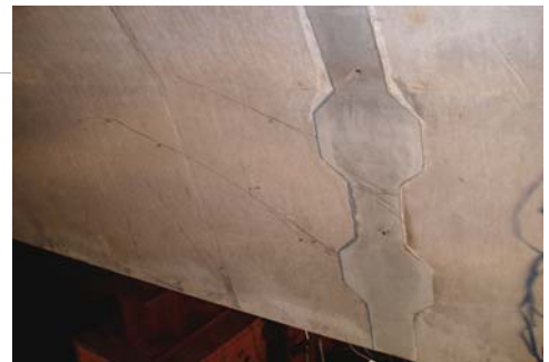
写真-6 クラック状況 (Bライン側)
