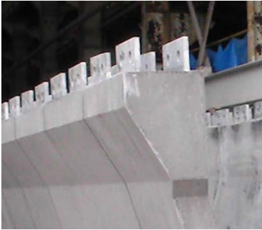
写真-1 UFC 桁 PBL 配置状況
