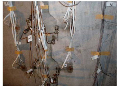
写真-5 クラック状況 (Aライン側)
