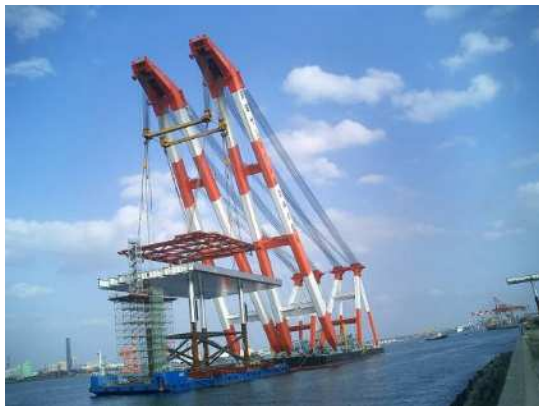
写真-8 完成ジャケットの積込と固縛方法
