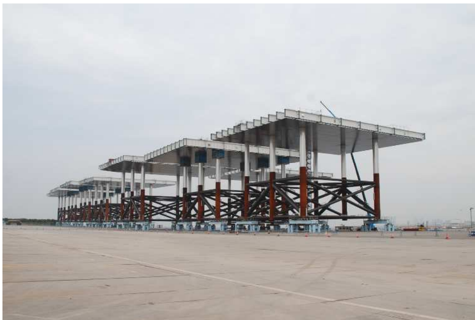
写真-9 一体化作業中のジャケットと出荷を待つ一体化ジャケット（2008年6月19日時点）
