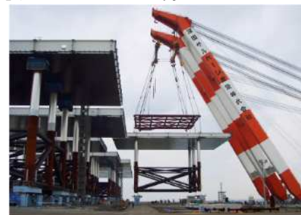
写真-1 下部、および一体化ジャケットの製作フロー写真
