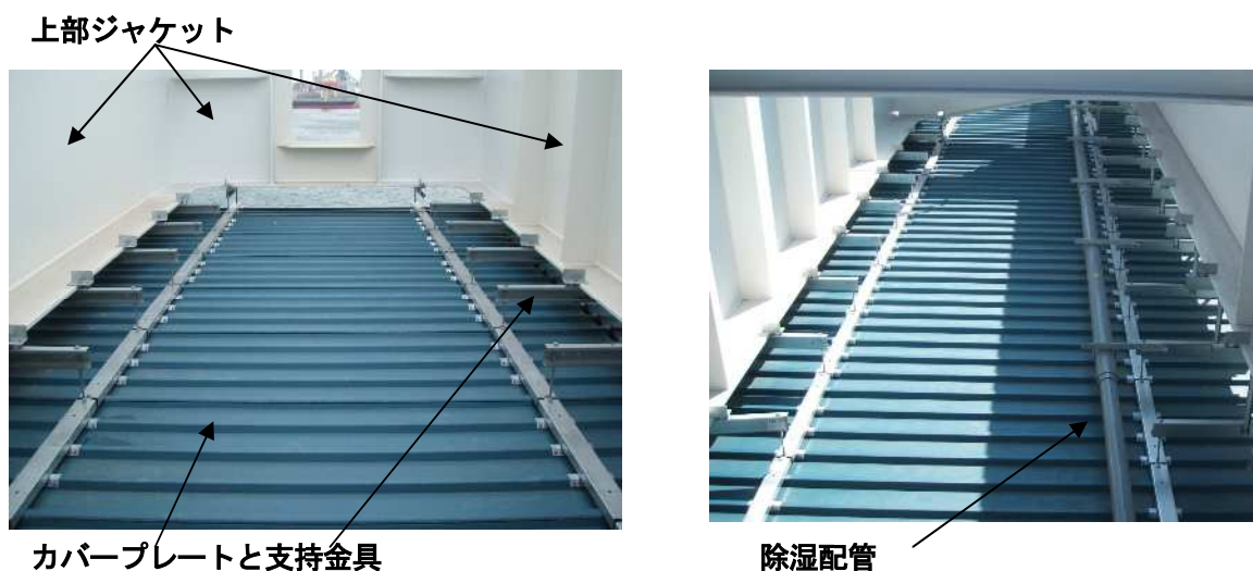
写真-4 カバープレート、および除湿配管取付状況
