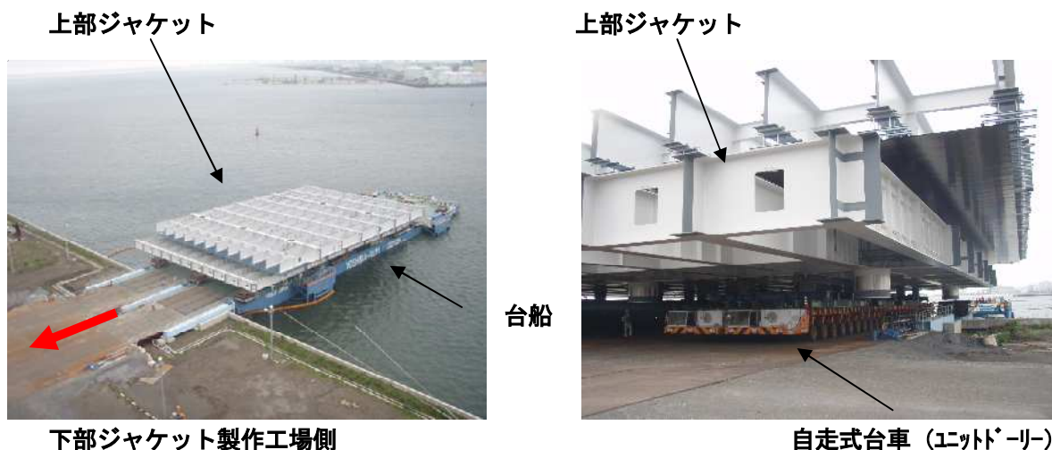
写真-3 下部ジャケット製作工場への上部ジャケットの搬入
