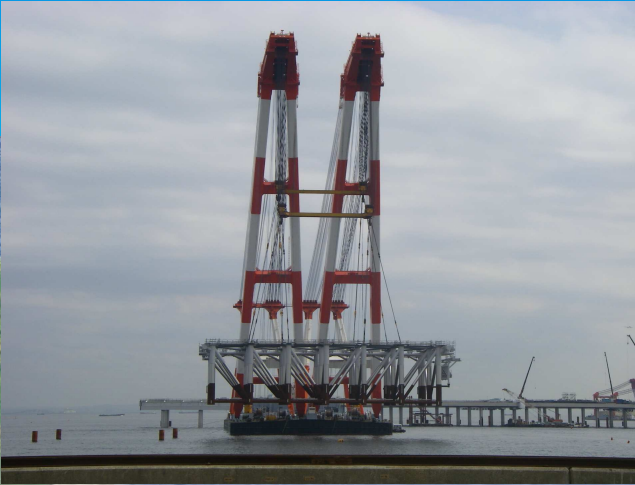
連絡誘導路ジャケツトパ-ス 標準タイプ：重さ約700t 高さ約15m
