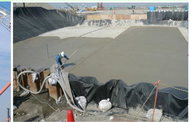
UFC桁上床版施工状況
