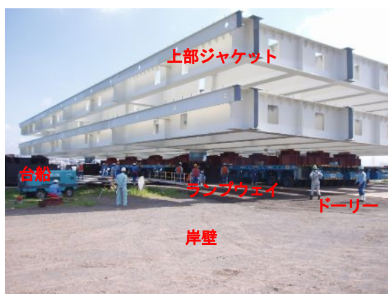
図-17 ユニットドーリーによる搬送
