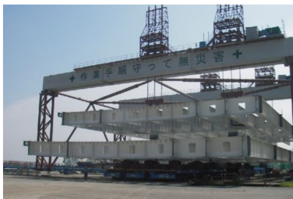
図-16 搭載架構による2段積み
