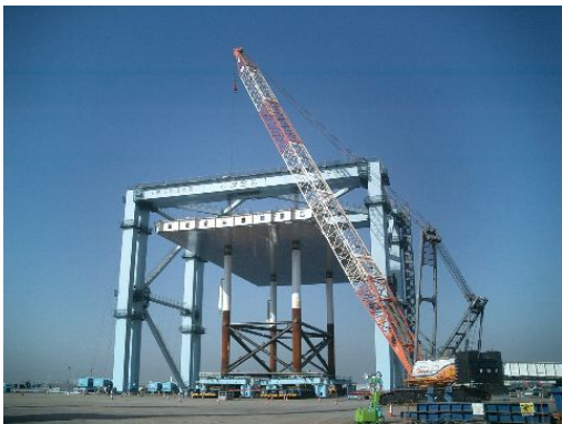
図-1.3 千葉工場における上下部ジャケット一体化
