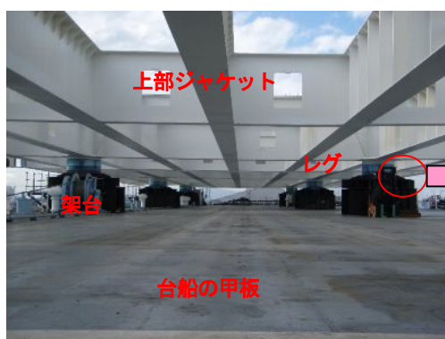
図-19 台船上での固縛状況
