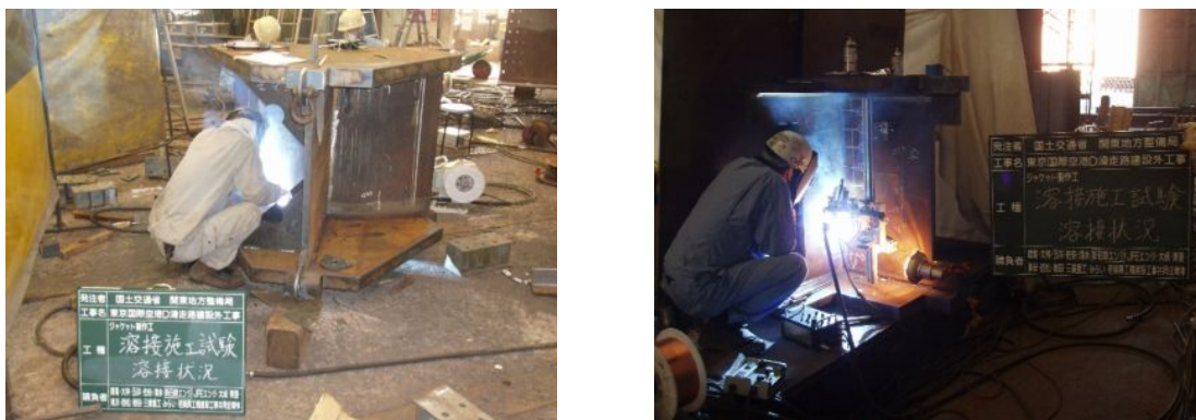
図-5 溶接施工試験の状況
