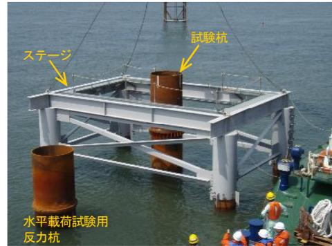
写真4-1 試験杭打設状況
