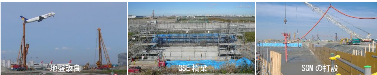
国際線地区（エプロン）における整備状況
