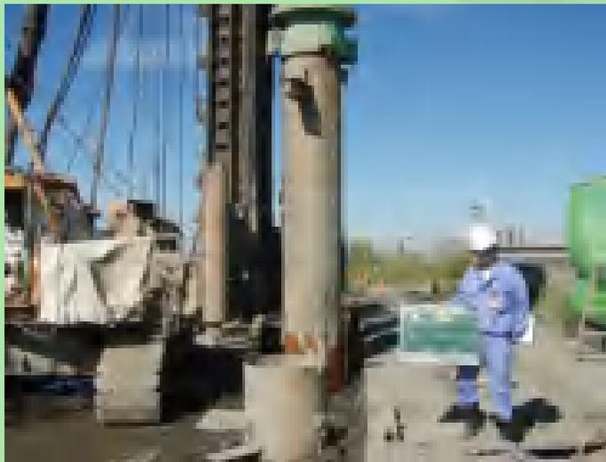
鋼管杭打設(GSE橋梁)
