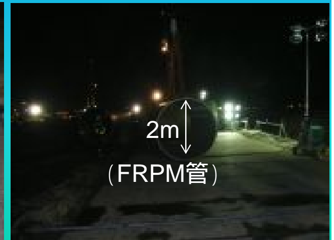
配水管の敷設
