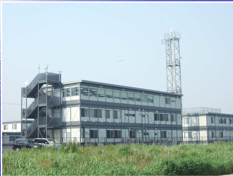
写真-3 「東京航行安全情報センター」棟
