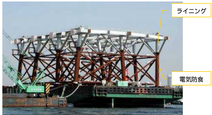
図5 耐海水性ステンレス鋼ライニング例
