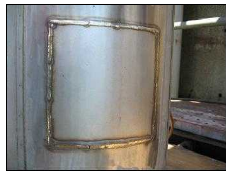
図 8-1 耐海水性ステンレス鋼ライニング補修試験状況
