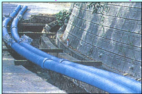
給水管(ポリエチレン管)
