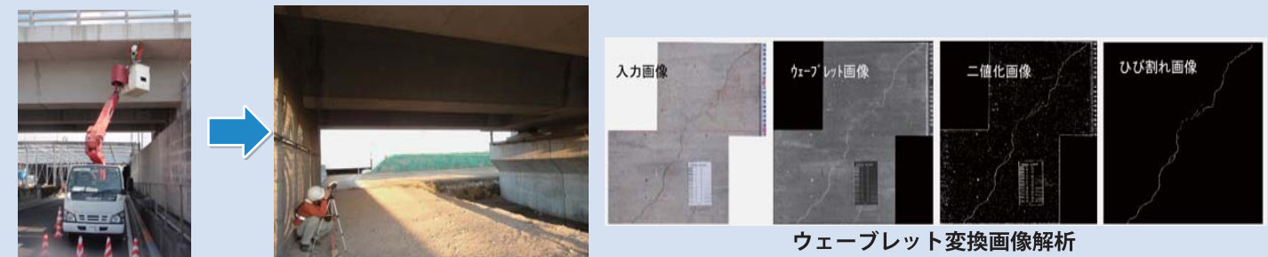
道路通行を規制しての点検
