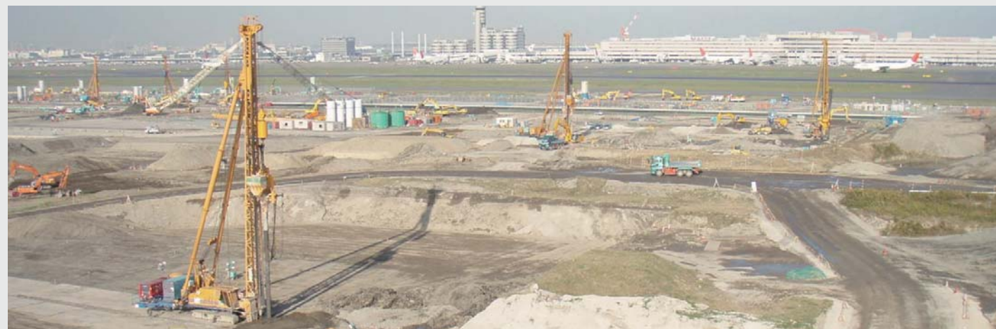
液状化対策工
