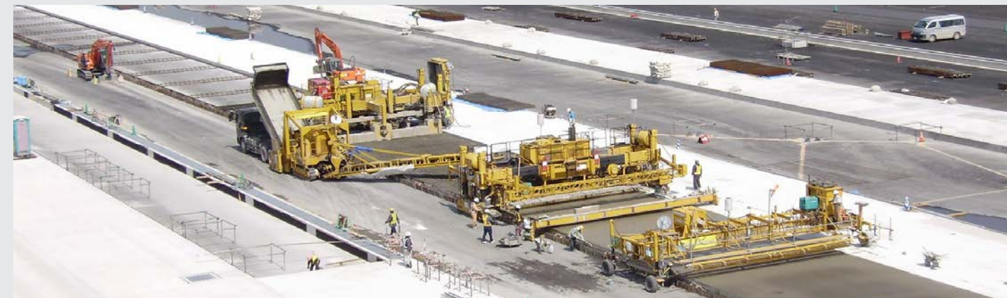
スリップフォームペーパー方式によるコンクリート舗装打設
